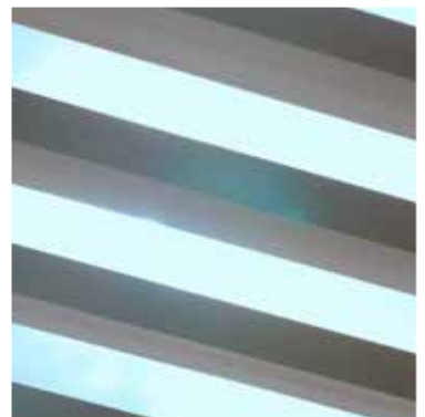
Grote roteerbare lamellen van 229 mm breed. Dit zorgt voor een strak en vlak aanzicht
